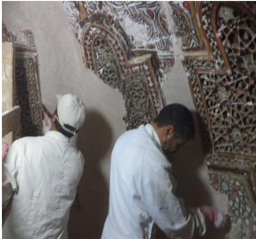
فريق الترميم اثناء عمليات إعادة تلبس البدن الداخلي للقبة الشمالية الوسطى (المصدر: تقرير صالح عطيف واحمد الجحاني).
