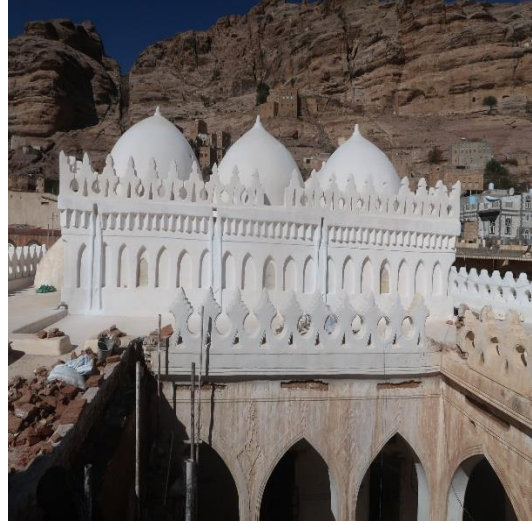
قباب بيت الصلاة من الخارج بعد تنفيذ اعمال القضاض (المصدر: كاميرا الزيارة - عادل سعيد)
