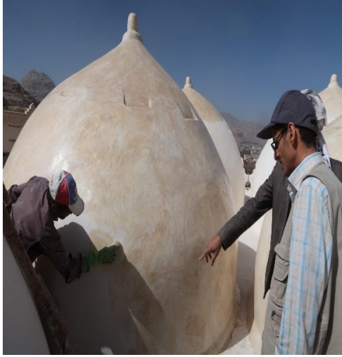
الاطلاع على اعمال التشحيم بالزيت الحيواني كطبقة أخيرة لقضاض قباب بيت الصلاة (المصدر: كاميرا الزيارة - عادل سعيد).
